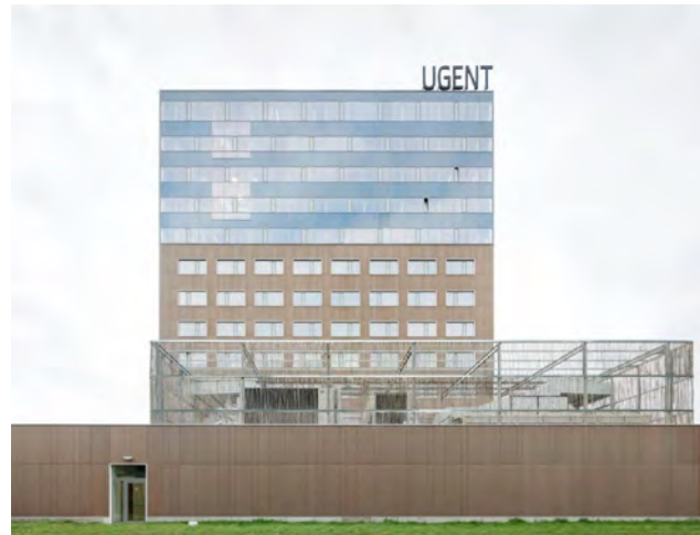
IGent, Evr Arch. localisé le long de l'autoroute E40, à Gand
