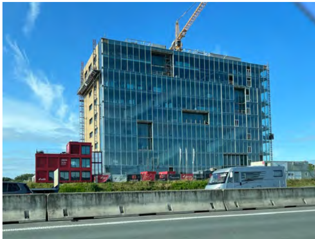
VIB Bio-Incubator (en chantier), Stephane Beel Arch. localisé le long de l'autoroute E40, à Gand
